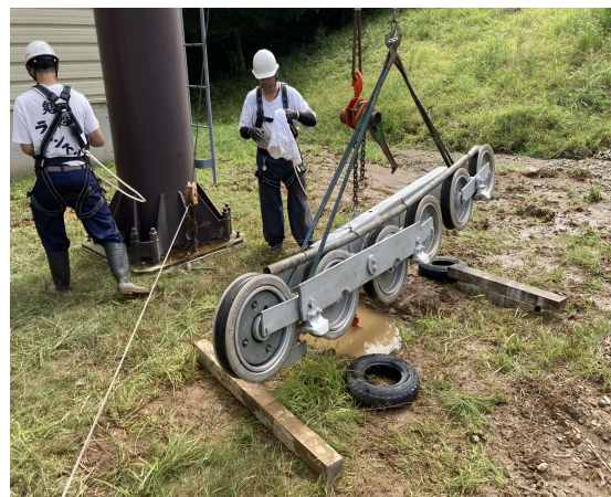
第2クワッドリフト支柱整備
